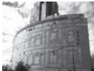
Oficinas Centrales Ferrovias Rusas Moscu - Rusia
